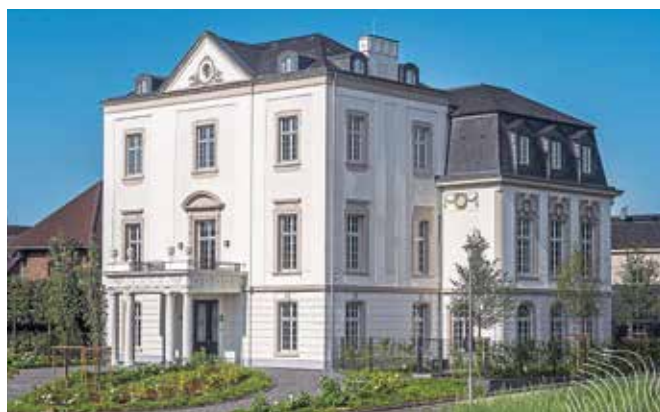
Brammertz lieferte die Fenster bei der Sanierung des Guts Kaisersruh nördlich von Aachen.
