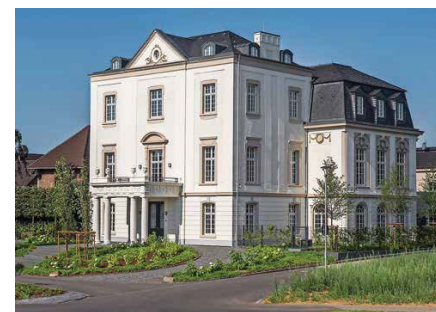
Großauftrag: Vor wenigen Jahren wurde das Gut Kaisersruh restauriert. Die Schreinerei Brammertz hat unter anderem die Fenster gebaut.
