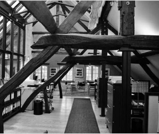
Büoräume unterm Dach: Eine moderne Glaskonstruktion erweitert das historische Dachgebälk.
