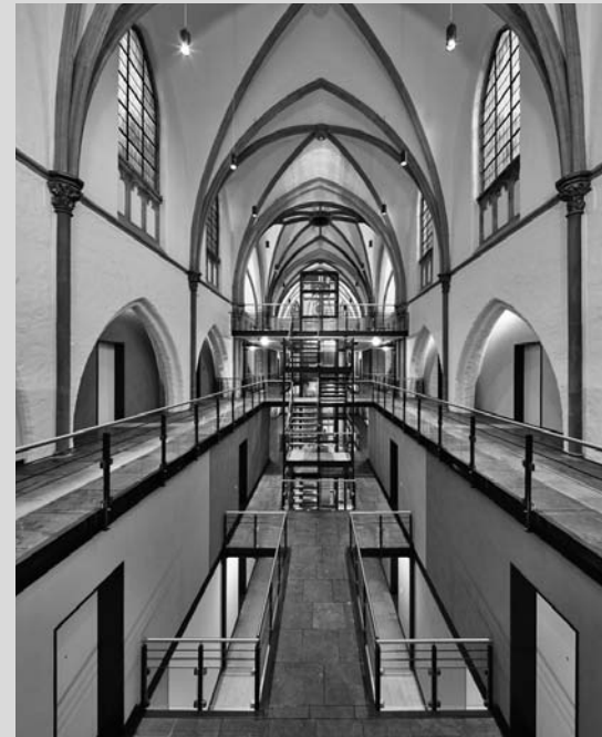
Zeitgemäße Nutzung: Die Herz-Jesu-Kirche in Mönchengladbach wurde nach ihrer Entweiung zum Apartment-Wohnhaus umgebaut.
