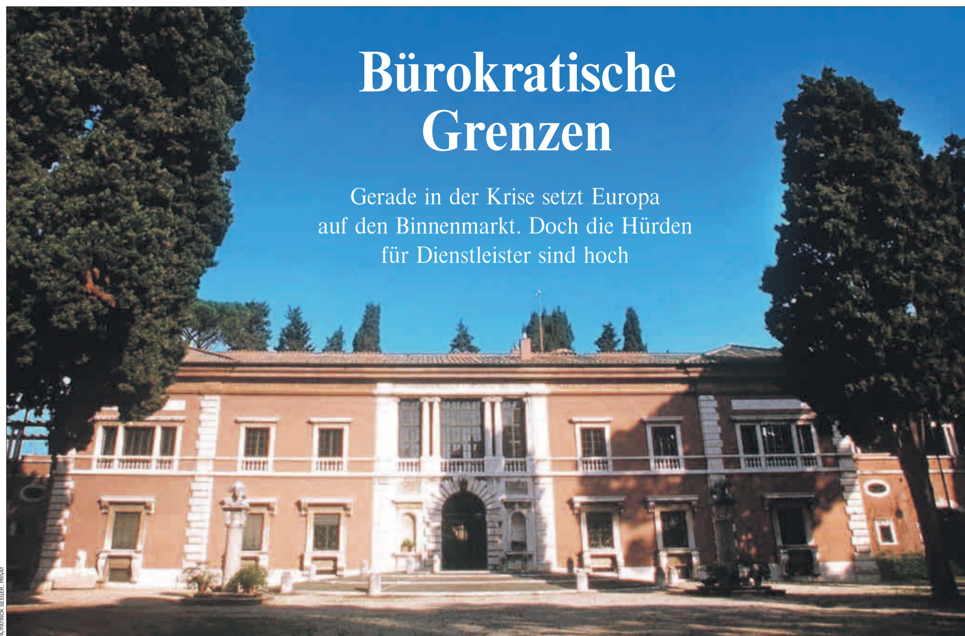
Die originalgetreu restaurierten Fenster der deutschen Kulturakademie bei Rom, der Villa Massimo, kommen aus dem deutschen Kornelilmünster
