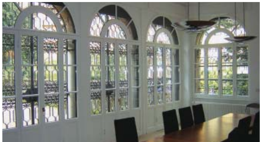
Meisterleistung in Sachen Denkmalschutz: die Sanierung der Villa Massimo im Rom
